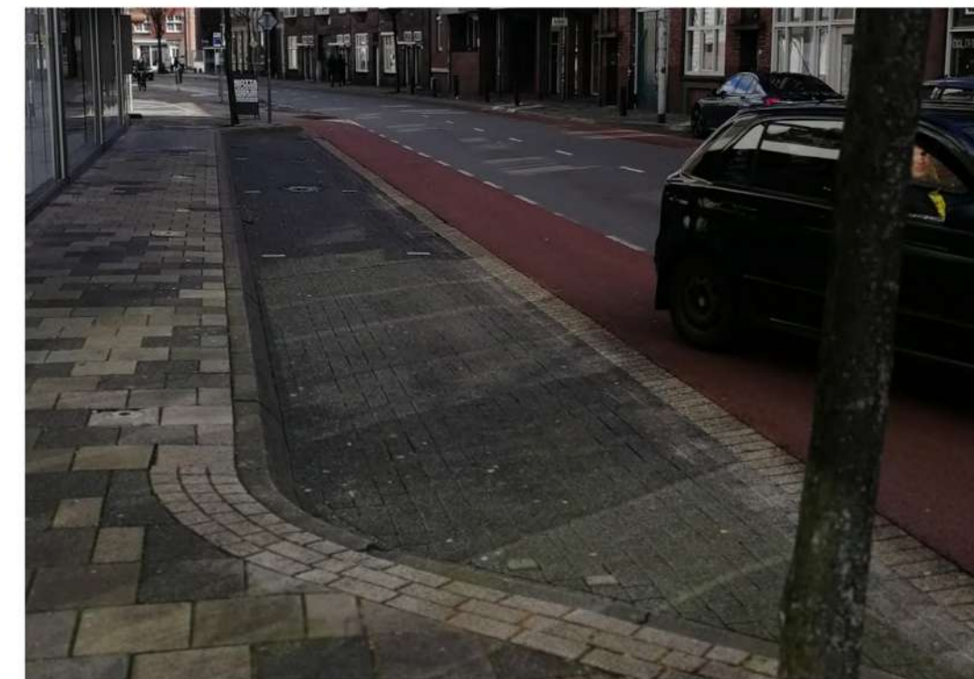
ХОРОШО. Мощение зоны парковки выполнено из плитки
