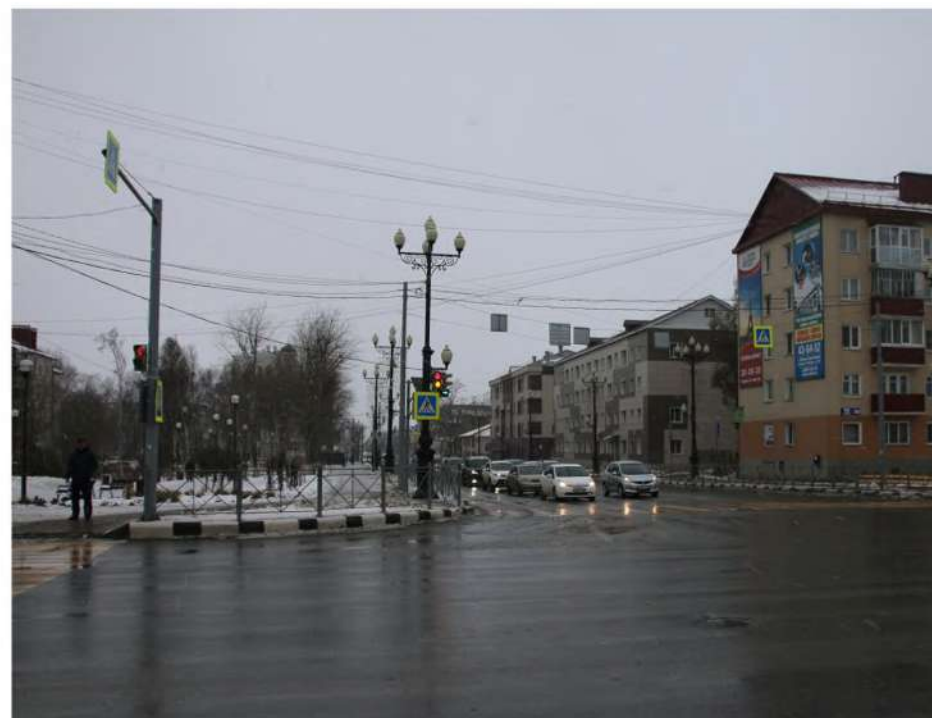
ПЛОХО. Излишнее количество светильников, воздушная прокладка проводов
