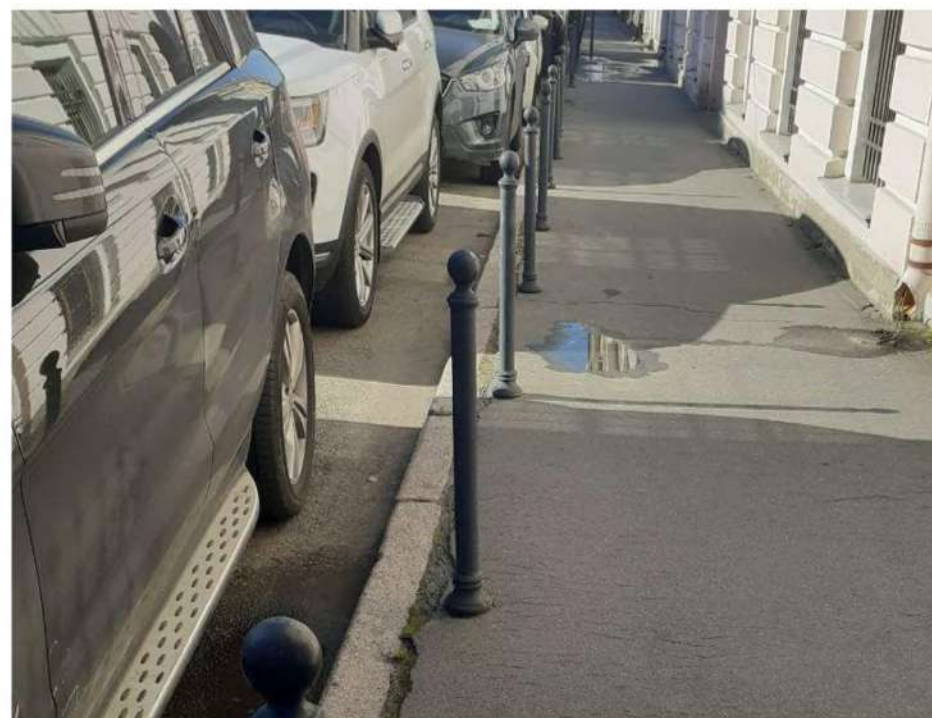
ПЛОХО. Покрытие пешеходного тротуара из асфальтобетона недопустимо
