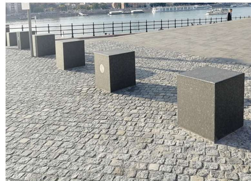
ХОРОШО. Бетонные ограничители могут использоваться в качестве дорожных ограждений
