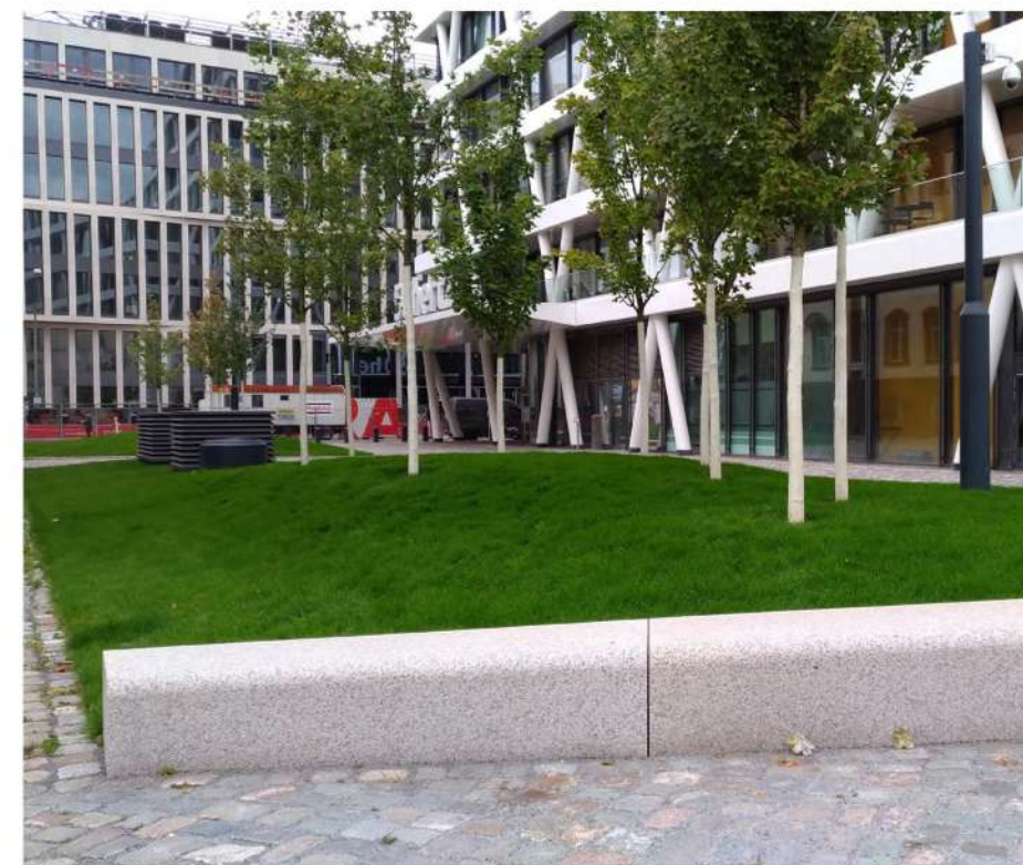
Использование геопластики с целью разделения пространства и создания необходимого объема грунта для посадки деревьев, Берлин
