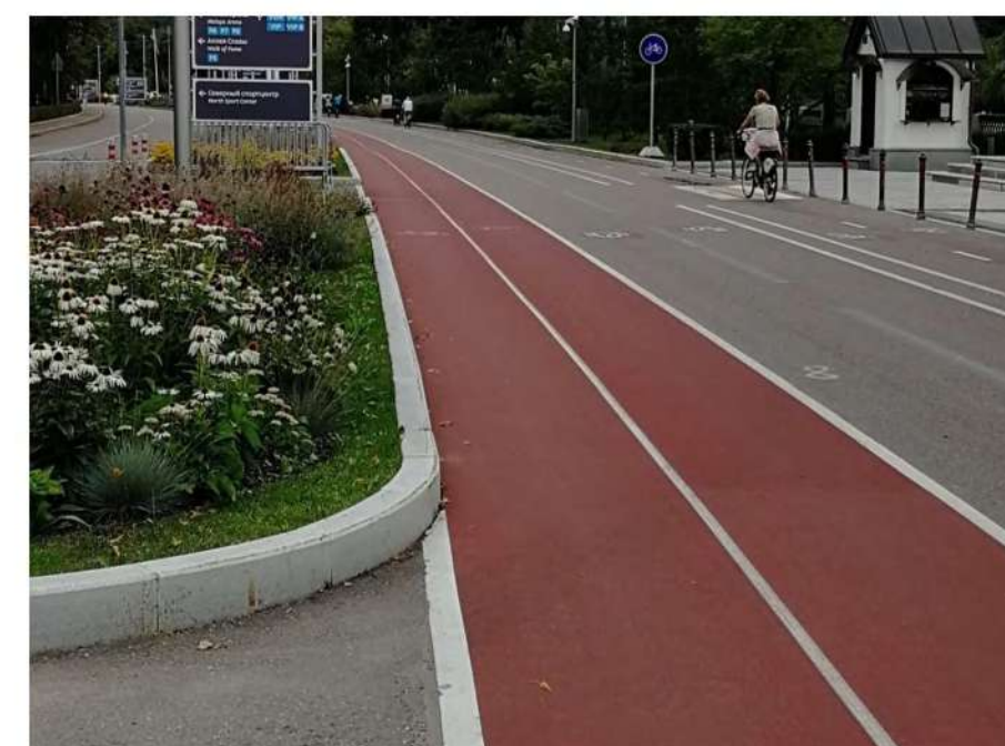
ХОРОШО. Мощение велосипедной полосы выполнено из цветного асфальтобетона
