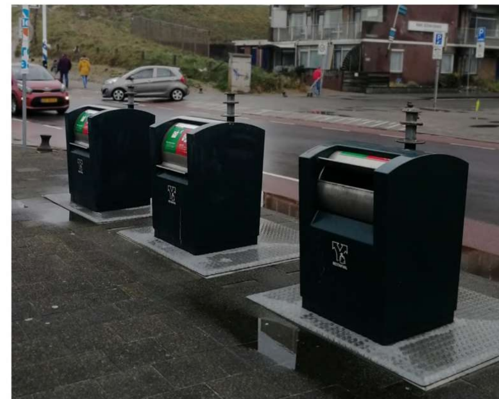
ХОРОШО. Подземное размещение площадок ТБО с разделным сбором мусора
