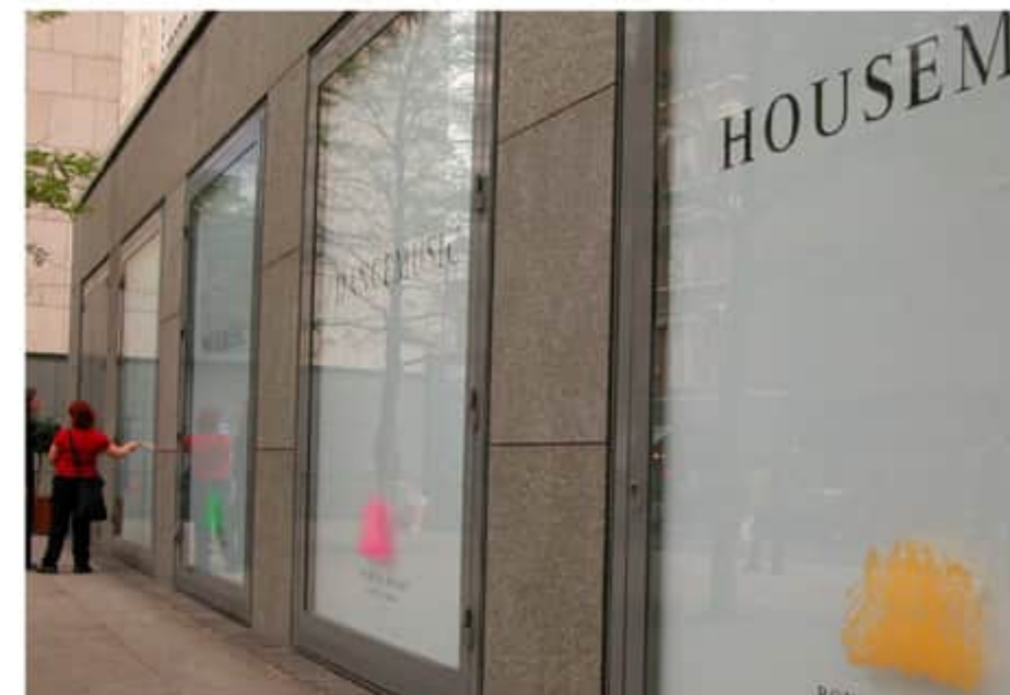
ПЛОХО. Остекление полностью закрыто
