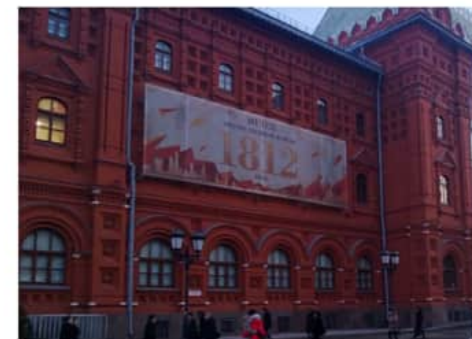
ПЛОХО. Баннер закрывает окна
