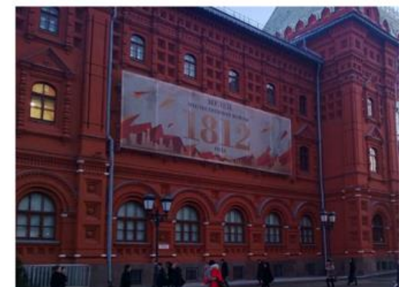
ПЛОХО. Баннер закрывает окна
