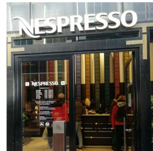
ПЛОХО. Вывеска без подложки не привязана к структуре здания, расположена на стыке остекления и простенка
