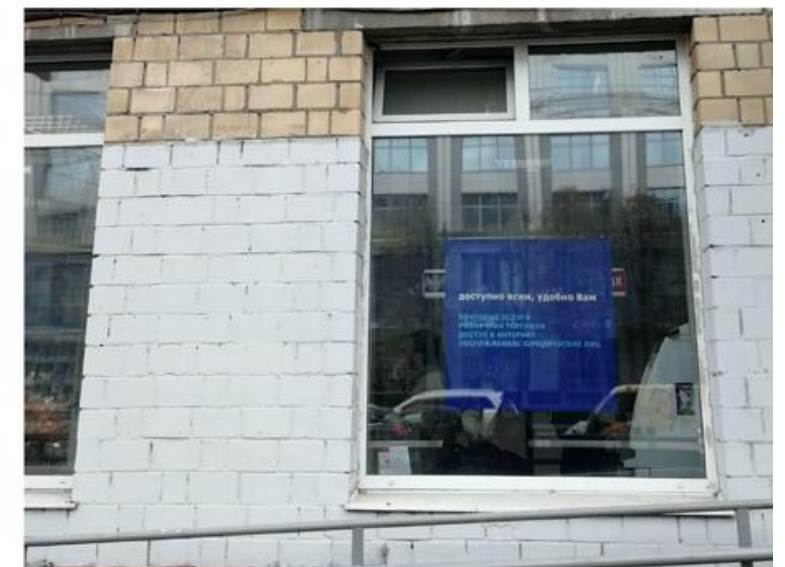
ХОРОШО. Носитель заглублен в интерьер здания, не портит архитектуру фасада, при этом заметен и хорошо читается
