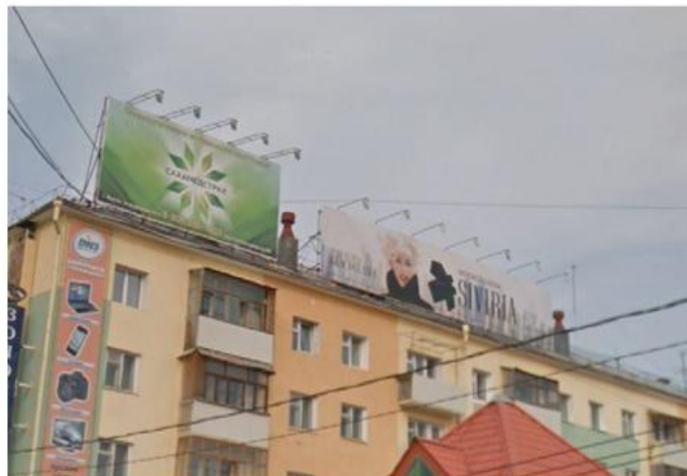
ПЛОХО. Использование крышных конструкций в качестве рекламы, размещение баннеров
