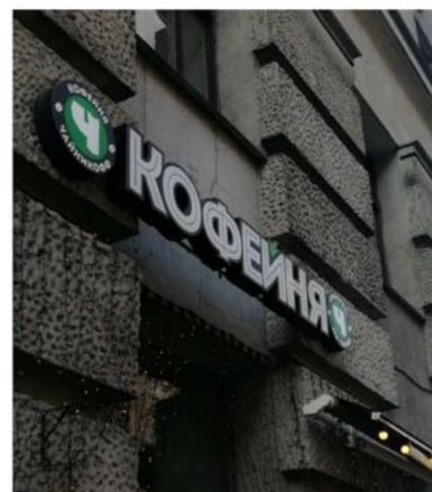
ПЛОХО. Расположение вывески не учитывает архитектуру здания
