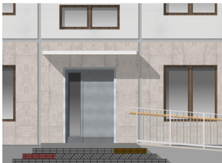
ПЛОХО. Лестница имеет фрагментарную отделку из разных материалов
