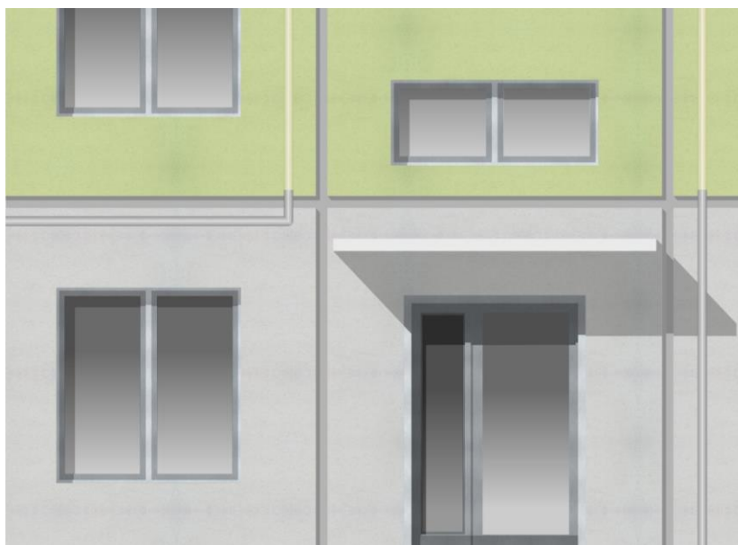
ХОРОШО. Инженерные провода проложены в коробах, выкрашенных в цвет фасада
