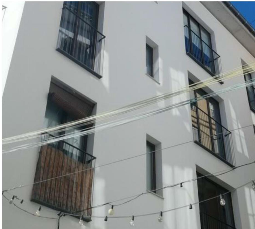
Окраска по штукатурке
