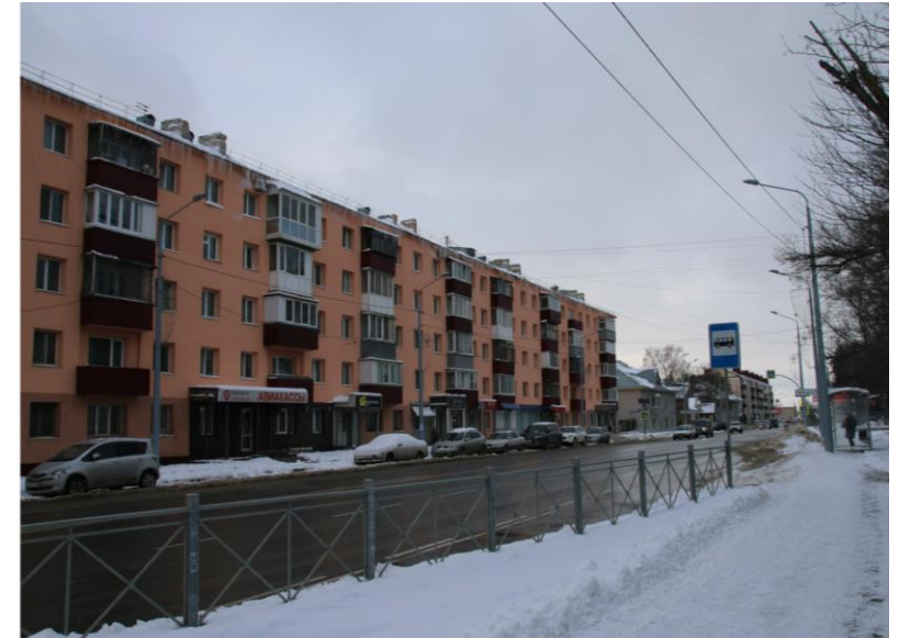
ПЛОХО. Сплошное ограждение препятствует уборке снега
