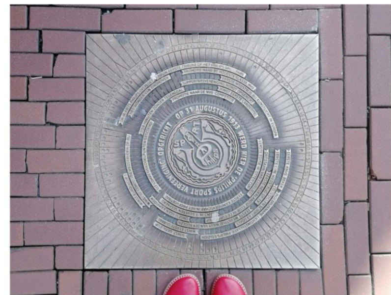
ХОРОШО. Крышка люка выполнена в интересном дизайне, подчеркивает идентичность города. Не имеет выпуклых частей, безопасна для пешеходов
