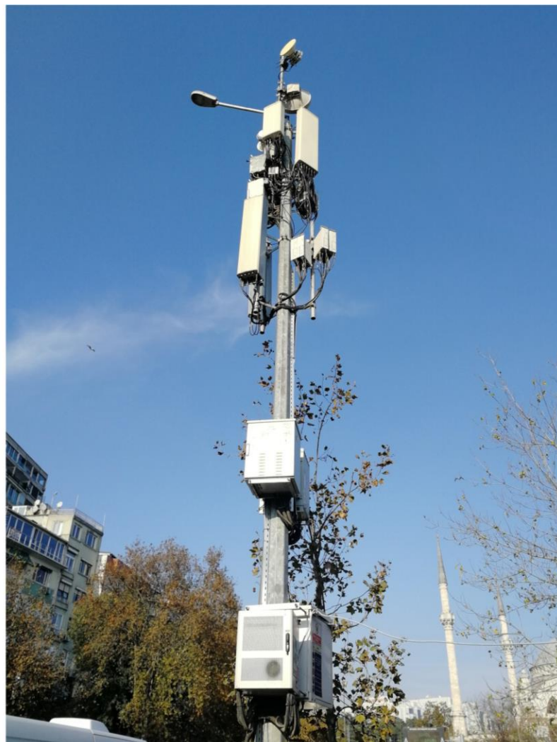
ПЛОХО. Излишнее количество навесного оборудования на дорожном столбе, создается визуальный шум
