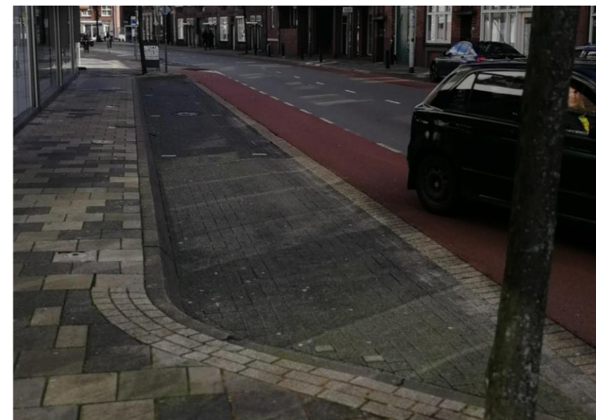
ХОРОШО. Мощение зоны парковки выполнено из плитки
