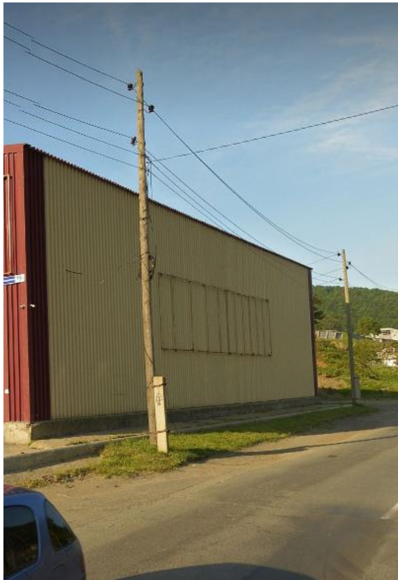
ПЛОХО: Использование деревянных опор линий электропередач в городской черте
