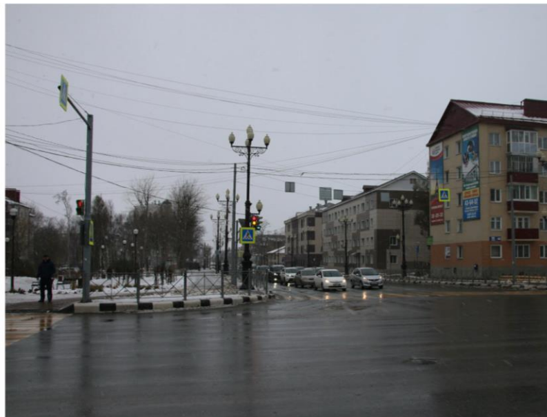
ПЛОХО. Излишнее количество светильников, воздушная прокладка проводов
